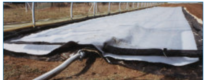
Ausgelegte und beschwerte Dämpffolie mit Isoliervlies
